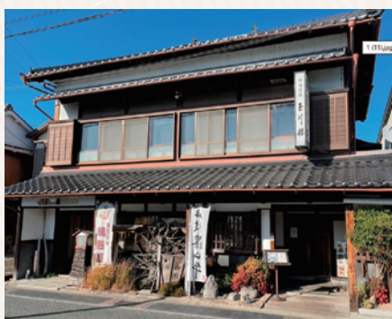
料理旅館 玉川楼
