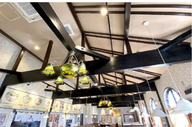
平屋建 建築面積180㎡【NK工法】 幹線道路沿いに建つ店舗。15m×6mの客席に柱無し。 梁や小屋組や火打が、内装として活かされ、洒落た室内を演出しています。
