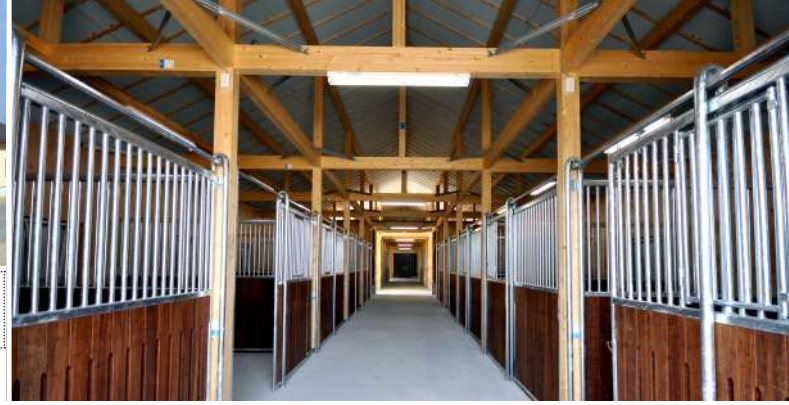
平屋建 建築面積380㎡【NK工法】栗東の厩舎 鉄骨よりもスリムで、工期が短く、仕上げが楽にできる、木造軸組の長所を活かしています。
