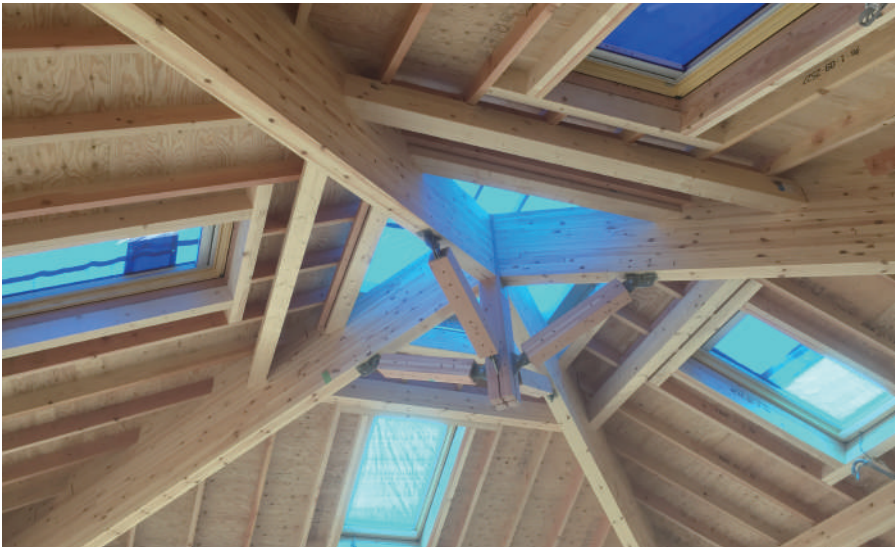
2階建・事務所用途 建築面積240㎡ 延床面積470㎡ 【NK工法+ATAハイブリッドトラス】 2階事務室は11m×16mの大空間 小屋組トラスはATAハイブリッドトラスによる張弦梁。
