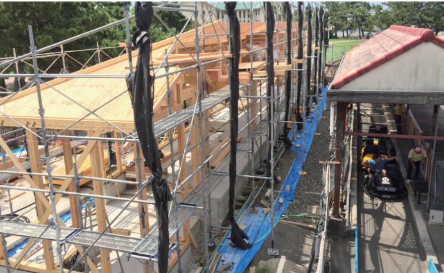
平屋建・遊園地SL駅舎 建築面積85㎡ 延床面積85㎡ 【NK工法+狭小耐力壁】 昨年(2018年9月)、台風21号で壊れて再建中です。 SLのホームにかかる大屋根。長辺方向の線路側は大開口、短辺方向は両端にしか「壁」が無く、木造にとっては厳しいプランです。
