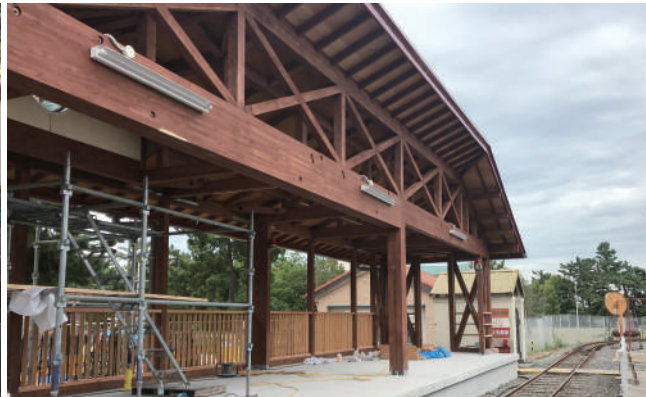
平屋建・遊園地SL駅舎 建築面積85㎡ 延床面積85㎡ 【NK工法+狭小耐力壁】 昨年(2018年9月)、台風21号で壊れて再建中です。 SLのホームにかかる大屋根。長辺方向の線路側は大開口、短辺方向は両端にしか「壁」が無く、木造にとっては厳しいプランです。
