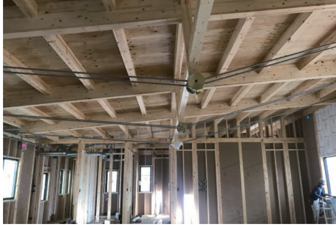
2階建・事務所用途 建築面積240㎡ 延床面積470㎡ 【NK工法+ATAハイブリッドトラス】 2階事務室は11m×16mの大空間 小屋組トラスはATAハイブリッドトラスによる張弦梁。
