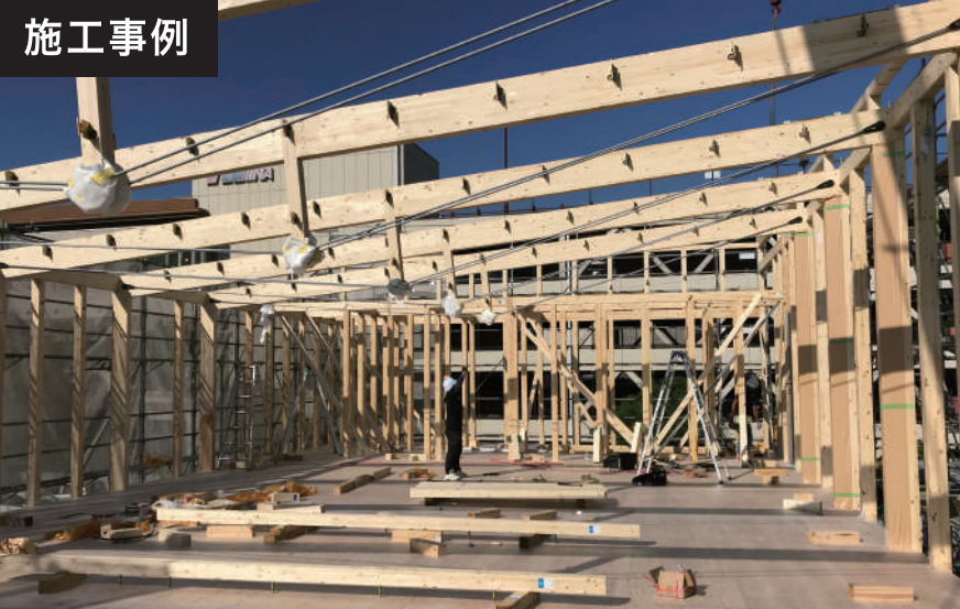
2階建・事務所用途 建築面積240㎡ 延床面積470㎡ 【NK工法+ATAハイブリッドトラス】 2階事務室は11m×16mの大空間 小屋組トラスはATAハイブリッドトラスによる張弦梁。
