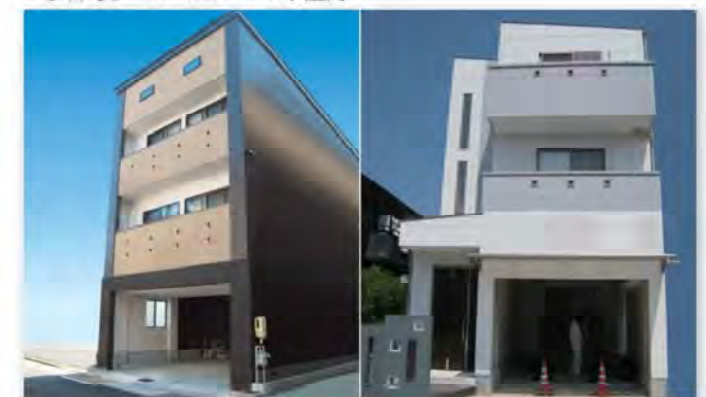
▲住宅 門型ラーメンを用いた3階建
